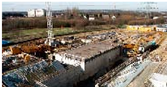
Blick in die Baugrube des „Tiefregallagers“
