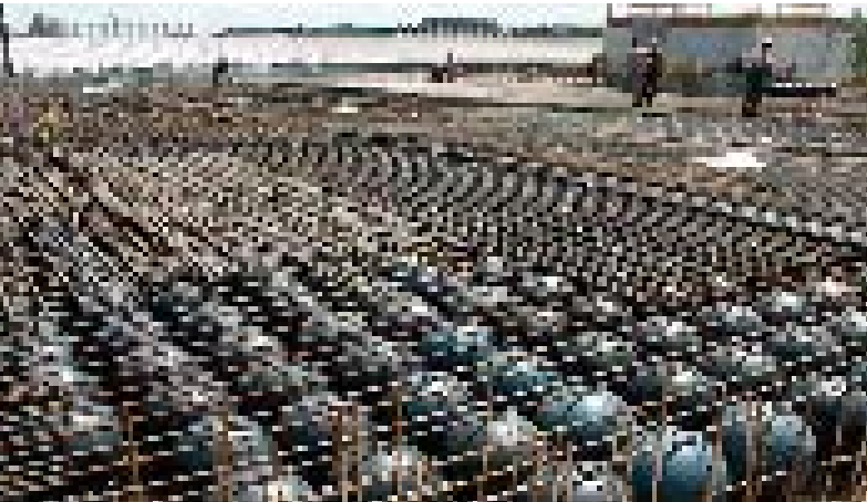
Hohlraumdecken nach dem „Bubble“-Prinzip
