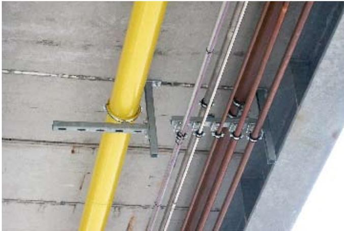
**Bild 6: An der Decke montierte Konsolen mit daran befestigten Rohren**
