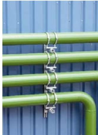
**Bild 7: An einer Außenwand montierte Konsole**
