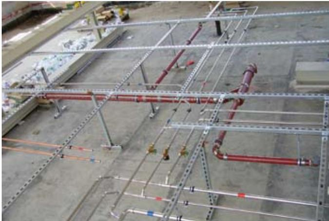
**Bild 2:** Ein Montagesystem über dem Rohfußboden mit mehreren Schienen während des Einbaus
