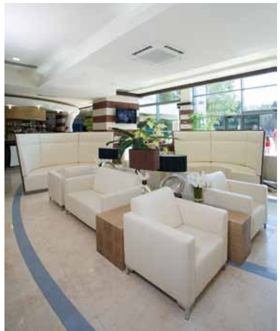
Hinsetzen und entspannen: Ein ausgereiftes Klimakonzept sorgt für ein perfektes Wohlfühl-Ambiente – zu jeder Jahreszeit, wahlweise im Heiz- oder Kühlbetrieb.
