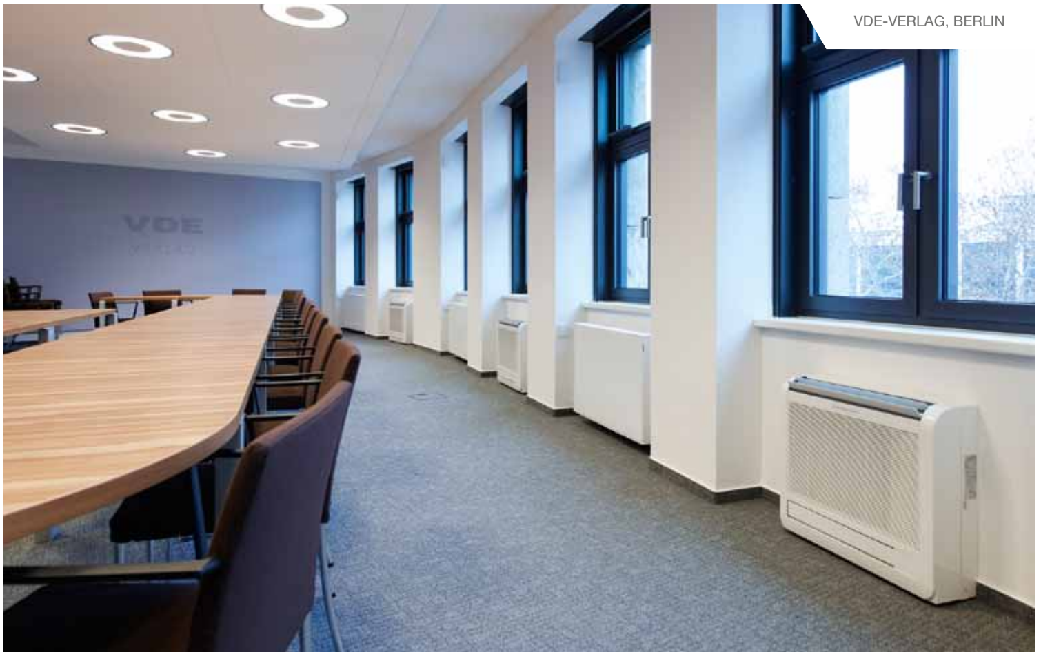
In jeder zweiten Nische wurde ein Klimatruhengerät untergebracht, um den Sitzungsraum im Sommer zu kühlen.
