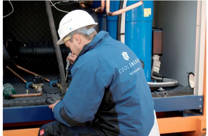
Bei dem Pilotprojekt von Vestas setzte CoolEnergy einen 75-kW-Kaltwassersatz und ein 50-kW-Lüftungsgerät auf Mietbasis zur Abkühlung von Rotorblattformen ein (li.). Mit dieser Technik bediente Vestas zwei von insgesamt vier Fertigungsplätzen im Wechsel und erreichte pro Platz eine Produktionssteigerung von zehn Prozent. Für die Installation der Anlage und die Beratung des Kunden vor Ort stehen erfahrene Service-Techniker (re.) und Planungs-Ingenieure von CoolEnergy zur Verfügung.
