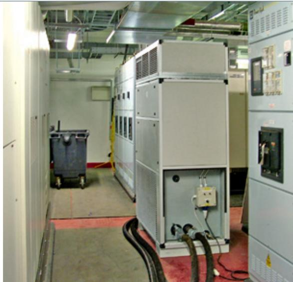
Während der Umbauphase der Serverräume klimatisierten EDV-Lüftungsgeräte die Räume. Die benötigten Wasserschläuche wurden speziell isoliert, um eine Kondensatbildung in dem hochempfindlichen IT-Bereich zu vermeiden. (Foto: Coolenergy)
