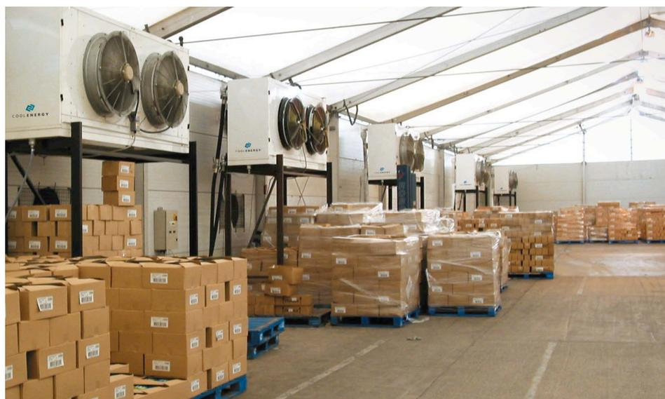
**5 x 50 kW Low-temp-Lüftungsgeräte mit Abtauautomatik. Lagerung von Lebensmitteln im temporären Lagerzelt**
