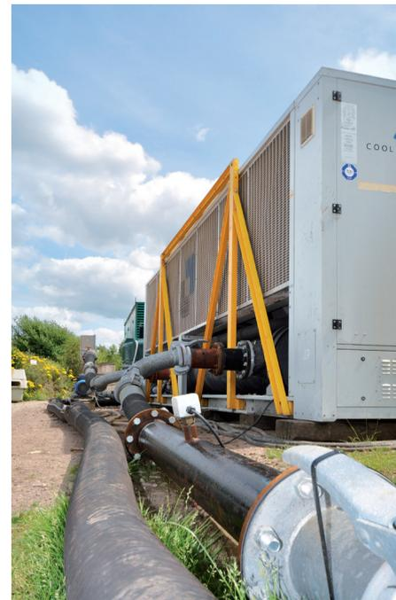
Abb. 3: Massive 6-Zoll-Schlauchleitungen verbinden den Kaltwassersatz mit dem vorhandenen System.
