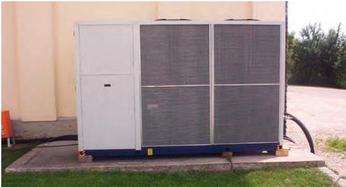
Ein solcher 21-kW-Kaltwassersatz wurde auf dem Gebäudedach installiert. Er versorgt neben dem Kühlraum zusätzlich Klimageräte im MSR-Schaltraum des Unternehmens
