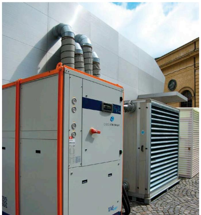
Der Wasserkühlsatz (links) und das Lüftungsgerät (Bildmitte) wurden im Außenbereich des Pavillons aufgestellt. Die Luft wird vom Lüftungsgerät über vier flexible Schläuche in den Innenraum gefördert. Die vier Anschlussstutzen sind oben zu erkennen.
