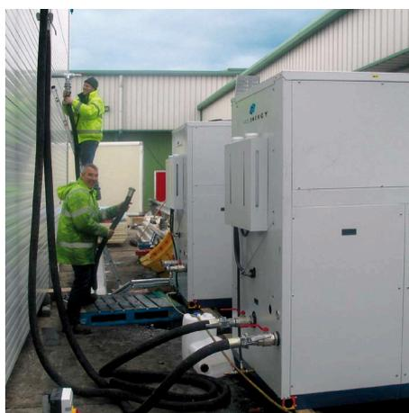
**Installation 2 x 130 kW Kaltwassersatz in Aussenaufstellung durch Servicetechniker zur Versorgung der innen aufgestellten Lüftungsgeräte**
