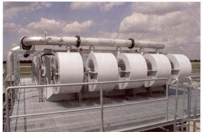
Kaltwassersätze auf Mietbasis, die mit chlorfreiem Kältemittel, z. B. R407C oder R134A arbeiten, realisieren den R22-Ausstieg (li.). Kompakte, modulare Kühlturmsysteme ersetzen veraltete Geräte mit zu hohem Wasser- und Wartungsbedarf (re.).
