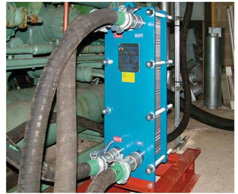
**Zum Installationspaket gehören lebensmittelechte Wärmetauscher zur Trennung des kundenseitigen Prozesses vom Kältekreislauf**
