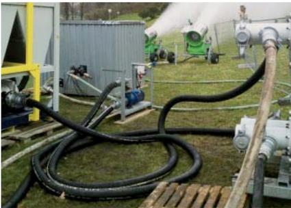
Mit einem leistungsstarken Miet-Kaltwassersatz (li. im Bild) kühlte man das Wasser für die vier Schneekanonen auf rund ein Grad ab, um optimale Schneeverhältnisse zu erreichen.
