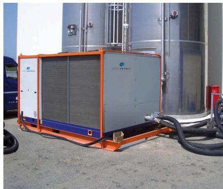
**220 kW Kaltwassersatz, luftgekühlt, zur Kühlung der Tanks in der Weinproduktion zur Gärführung, Mostkühlung oder Weinsteininstabilisierung**
