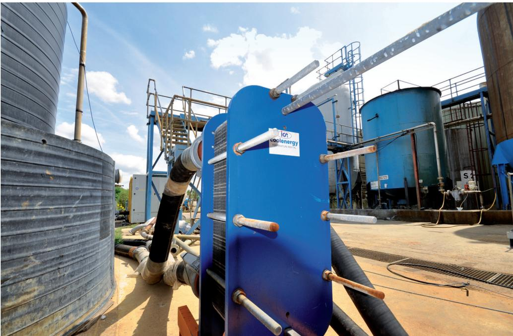
Abb. 2: Ein Baustein der Anlage ist dieser leistungsstarke Plattenwärmetauscher.
