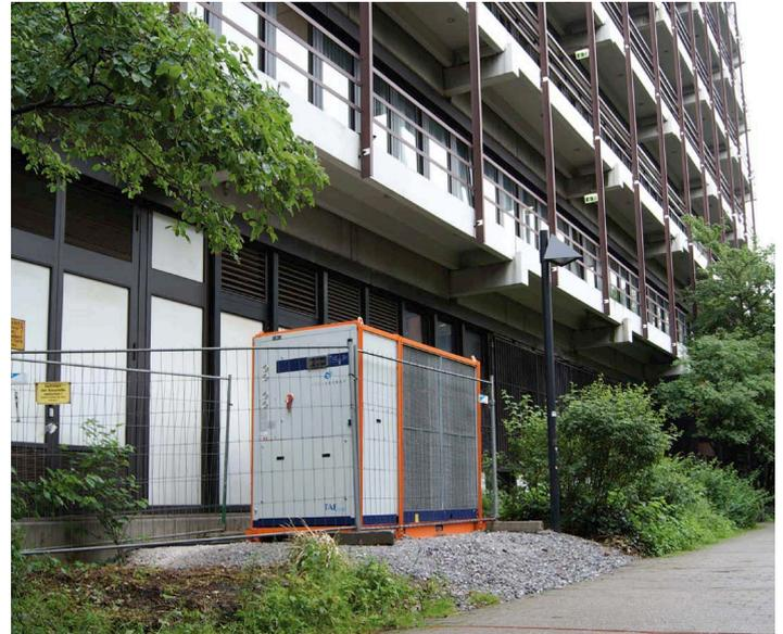
Ein im Außenbereich positionierter Kaltwassersatz mit einer Kälteleistung von 130 Kilowatt versorgt die EDV-Lüfter.
