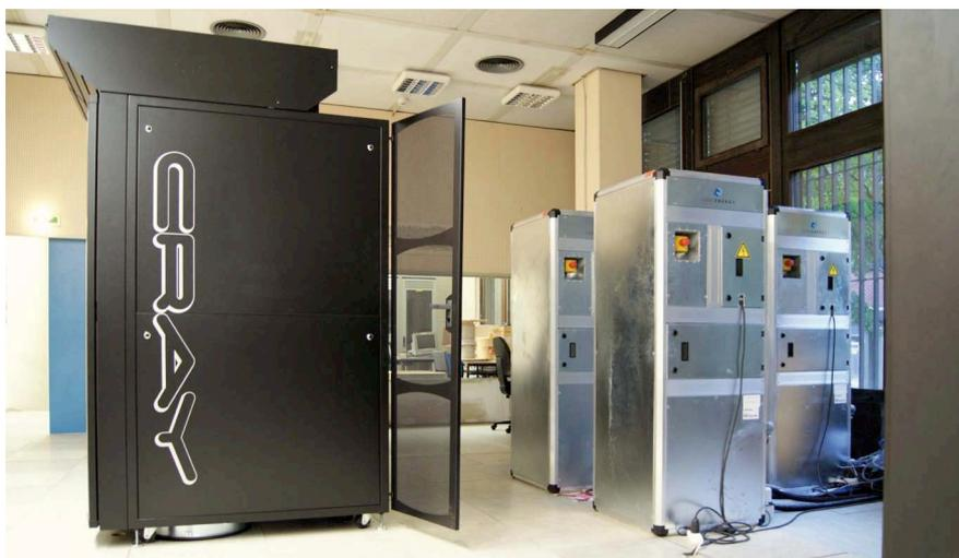
Insgesamt vier EDV-Lüftungsgeräte (drei davon im Bild re.) blasen Kaltluft durch Öffnungen in den Doppelboden des Serverraumes. Die Ansaugventilatoren des neuen Rechners nehmen die heruntergekühlte Luft aus dem Doppelboden auf.
