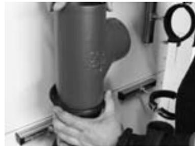
3. Nächstes Rohr oder Formstück bündig auf den Distanzring aufsetzen und die umgestülpte Hälfte der Manschette wieder zurückklappen.
