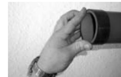
2. Schlauchstück 74/79 auf SML-Rohr oder Formstück DN 70 aufstecken
