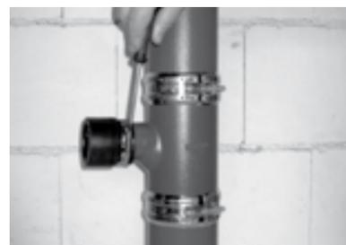
1. Düker EK Fix Manschette mit geöffnetem Spannband bis zum Anschlag auf das SML-Rohr schieben, dann mit Spannband am Rohr befestigen.
