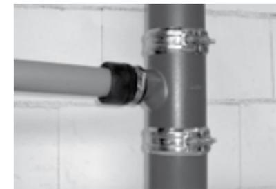
4. Das hier verwendete Kunststoffrohr veranschaulicht den Montagevorgang. Achtung: Durchmesser für Anschlussrohr-Außendurchmesser beachten!
