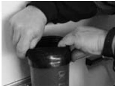
1. Zuerst wird die Dichtmanschette auf das untere Rohr geschoben, und zwar so, dass der innere Distanzring gleichmäßig auf der Schnittfläche des Rohres aufliegt.
