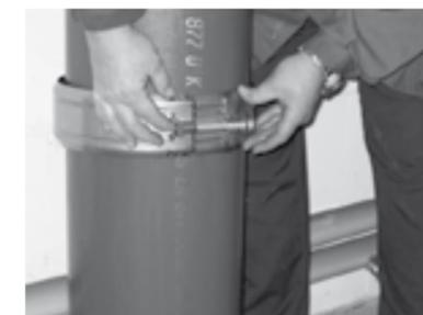
4. Schraubenkopf mit Tellerscheibe in Spannkopf einhängen.
