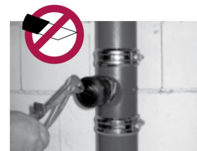
2. Der hervorstehende Gummizapfen auf der Stirnseite wird mit einer Zange gegriffen und mit Kraft vorsichtig herausgezogen, so dass der Deckel die Öffnung freigibt.
