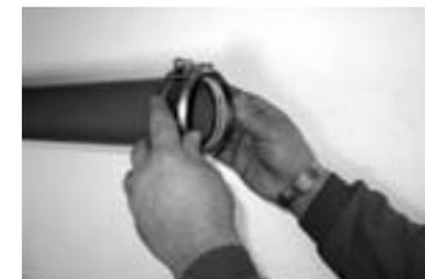
1. Rapid-Verbinder DN 80 auf SML-Rohr bzw. Formstück DN 80 aufstecken
