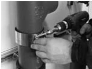
5. Die beiden Spannschrauben wechselseitig, gleichmäßig und handfest anziehen. Führungs- und Gewindeplatten des Verschlusses müssen sich parallel zusammenschieben, damit keine Verformungen entstehen können.
