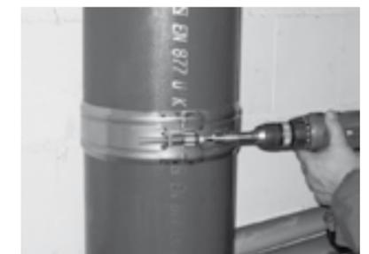
5. Innensechskantschraube mit Steckschlüssel, Handratsche oder Schlagschrauber anziehen, bis beide Spannköpfe zusammenstoßen.
