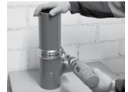
3. Innensechskantschraube mit Steckschlüssel, Handratsche oder handelsüblichem Akkuschauber anziehen. Dükorapid® DN 50–150: 10–20 Nm, Dükorapid® DN 40 und 200, Rapid Norma, Rapid Inox, Rapid MSM: bis beide Spannköpfe zusammenstoßen MLetec® Rapid: 15–25 Nm
