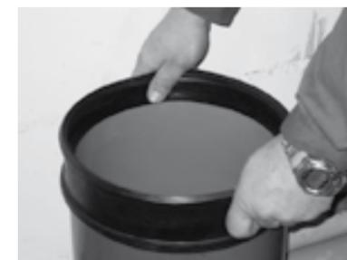
1. Dichtmuffe bis zum mittleren Distanzring aufstecken.
