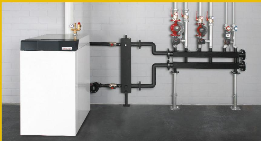
Gas-Brennwertkessel WTC-GB mit Hydraulikkomponenten (ohne Wärmedämmung)
