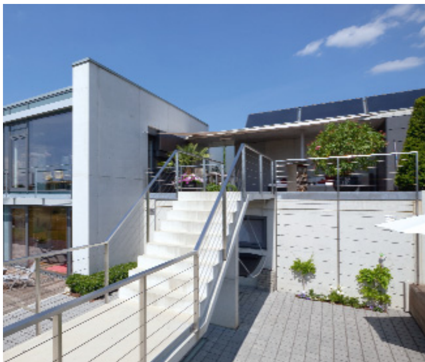
Bei der Flachdachmontage werden die Kollektoren aufgeständert.
