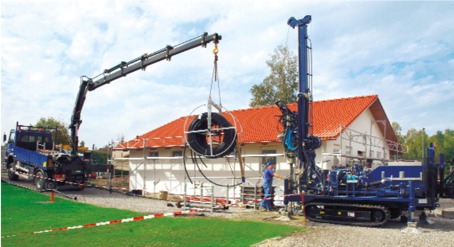
Eine gute Vorplanung erleichtert die Erdsondenbohrung.
