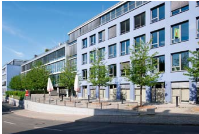
Großzügige Fensterflächen und die damit verbundene Sonneneinstrahlung machen die Abfuhr von Wärmelasten in bestimmten Bereichen erforderlich
