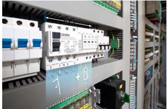
**Bild 3:** Mit einer Baubreite von nur 120 mm ist der „Kombi-RCD“ für diese Leistungstärke extrem schmal – so bleibt ausreichend Platz für Erweiterungen im Schaltschrank
