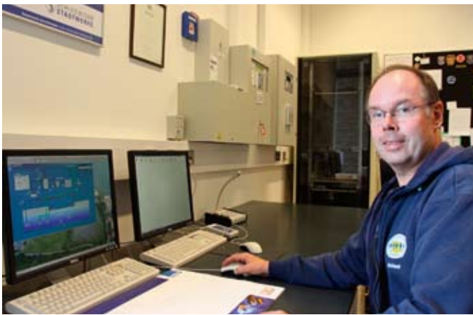
Hausmeister Michael Ramm mit „Desigo Insight“-Visualisierung; hinten im Bild die Brandmeldezentrale „Sigmasy M Sinteso“ und die Einbruchmeldeanlage „IC 2000“
