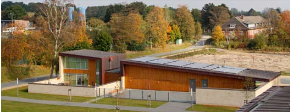
Blick auf das Hausmeister- und Werkstattgebäude mit Solaranlage; hier befindet sich auch die Fernwärmeübergabestation
