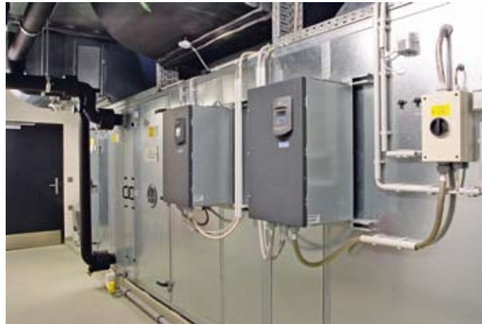
Lüftungsgerät mit „SED2“-Frequenzumformern zur stufenlosen Regelung der Luftmenge in Abhängigkeit der Raumluftqualität (CO 2 -Gehalt) in den Schulräumen
