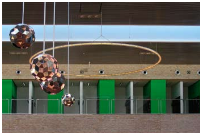
Ein Teil der Luft für die Aula wird über Weitwurfdüsen oberhalb der Garderobengalerie eingebracht; das Kunstobjekt „Tellurium“ bildet unser Sonnensystem ab
