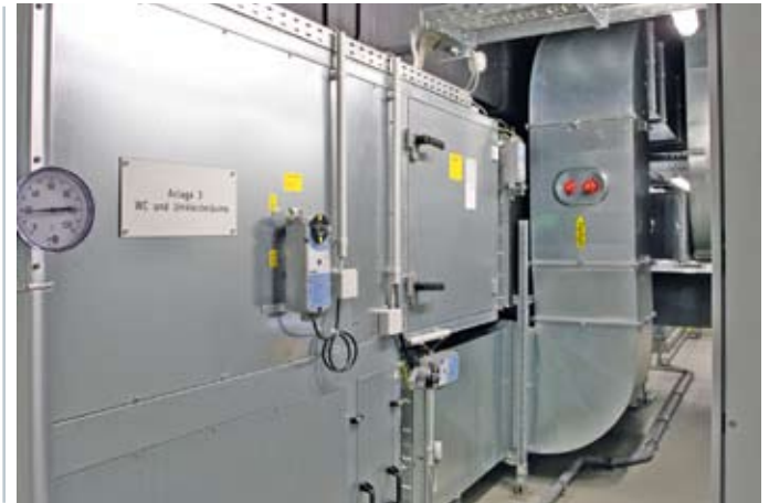
Alle Zentralklimageräte sind mit Kreuzstrom-Wärmerückgewinnern ausgerüstet; die mechanische Regelung erfolgt über Luftklappen-Drehantriebe von Siemens
