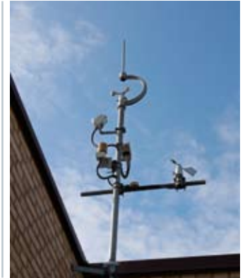
Die Wetterstation liefert sowohl Daten an das Gebäudeautomationsystem als auch für den Unterricht
