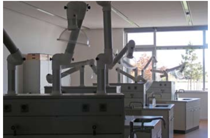
Funktionsräume wie für den Chemie- oder Physikunterricht sind zusätzlich zur Grundlüftung mit einem speziellen Abluftsystem ausgerüstet
