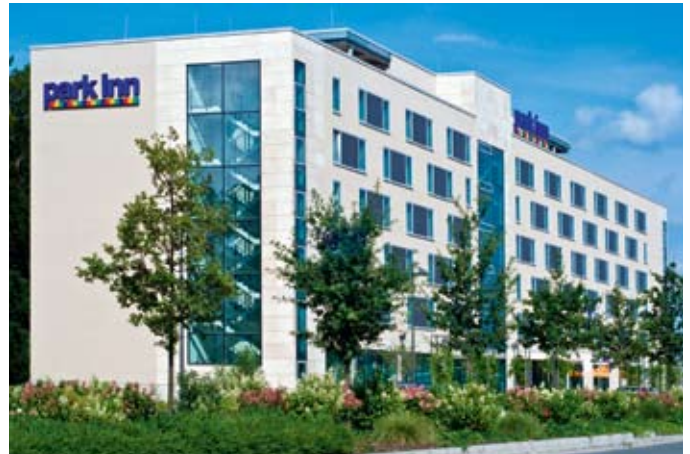
Die Park Inns zeichnen sich durch eine klare Gebäudestruktur aus
