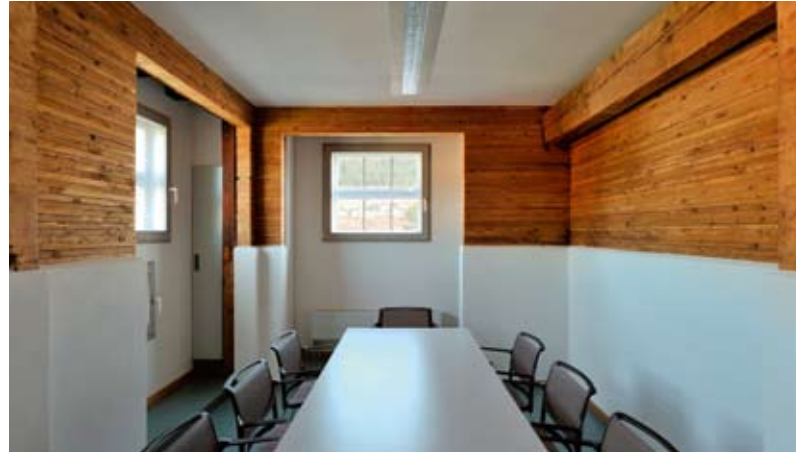
Der Besprechungsraum befindet sich in einer der ehemaligen Silozellen, deren Brettstapelwände erhalten blieben; lediglich im unteren Bereich sind die Innenwände verputzt, um mehr Licht in die Räume zu bekommen
