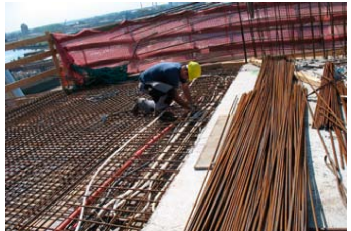
Die werkseitig vorgefertigten „Contec“-Module werden mit der patentierten Aufzugsträgermethode von der bauseitigen Bewehrung abgehängt; diese Montage erlaubt genaue Platzierung der Rohrregister in der Betondeckenmitte
