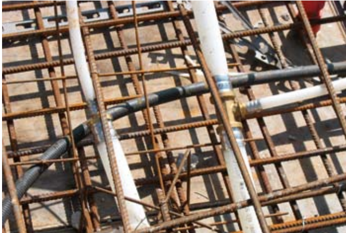
Für das Heizungs- und Kühlrohr verwendet der Systemhersteller das Polyethylenrohr (PE-Xa) in einer Nennweite von 20 x 2,3 mm
