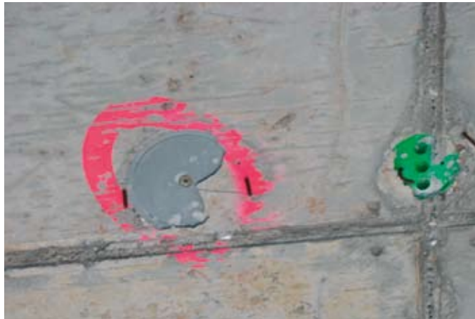
... rund 1000 Thermische Steckdosen zur Installation von Deckensegeln zum Heizen und Kühlen eingebaut
