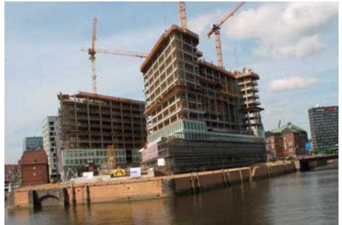
Auf sturmflutsicheren Sockeln erhebt sich über 13 Geschossen die lichte und transparente Architektur, entworfen von dem Architektenteam des dänischen Büros Henning Larsen mit 30 000 m 2 Bruttogeschossfläche
