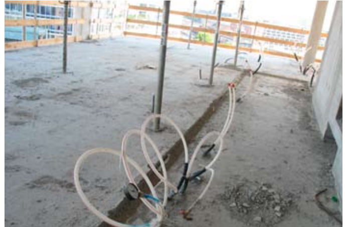
In einer sehr komplexen und anspruchsvollen Deckenkonstruktion wurden in diesem Projekt ...
