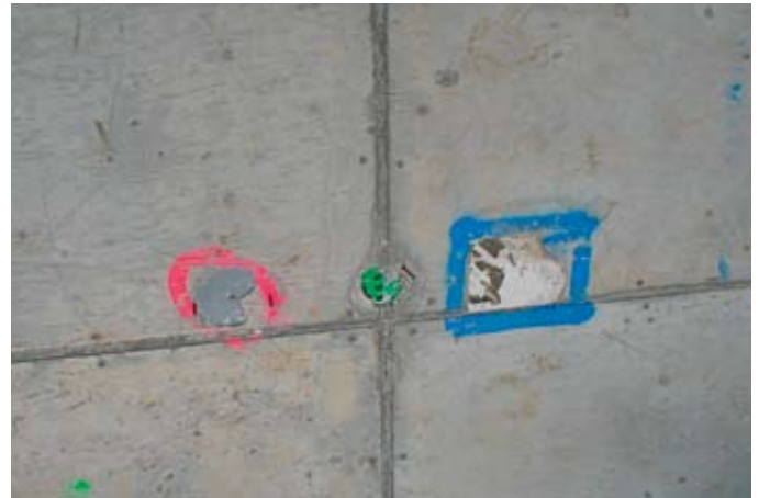
Eine große Herausforderung bei der Planung war ebenfalls die Koordination der in der Decke zu integrierenden, zusätzlichen Leerrohre oder auch Brandmelder
