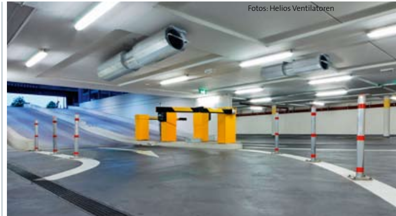
Bild 1: Impuls-Ventilatoren (hier im Bild die axiale Ausführung) zur Be- und Entlüftung sowie Entrauchung einer Parkgarage
