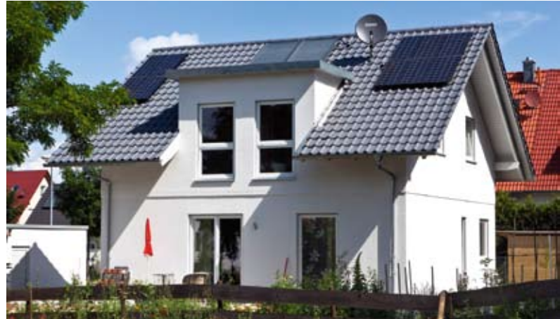
Das KfW 60-Haus der SchwörerHaus KG ist mit einem System zur kontrollierten Wohnraumlüftung mit Wärmerückgewinnung ausgestattet, ebenso mit einer Photovoltaikanlage für die Stromerzeugung und mit einer Solarthermieanlage für die Warmwasserbereitung
