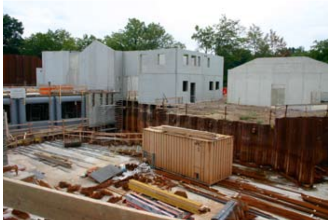
Blick über die im Bau befindlichen Wasserbecken zum ...
