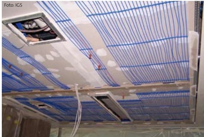
Bild 6: Clina-Kapillarrohmatten
