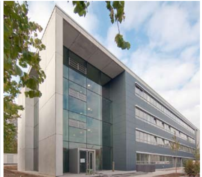
Der erste Ersatzneubau für das ehemals zentrale „Allgemeine Verfügungszen-trum“ ist multifunktional und interdisziplinär nutzbar
