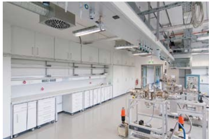
Laboreinrichtungen mit der Medienversorgung von der Decke aus
