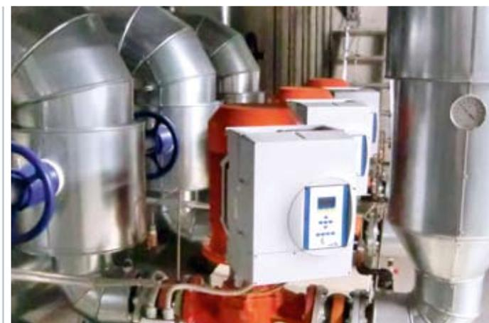
Wo große Fördermengen und hohe Drücke erforderlich sind, gleichzeitig sich aber laufend die Entnahme oder Umwälzmenge verändert, passt die von KSB entwickelte Pumpendrehzahlregelung „PumpDrive“ die Förderleistungen dem jeweils momentanen Bedarf an
