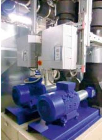
Die Pumpendrehzahlregelung „PumpDrive“ ist für den parallelen Betrieb von bis zu sechs Pumpen konzipiert und für eine Motorleistung bis 45 kW einsetzbar
