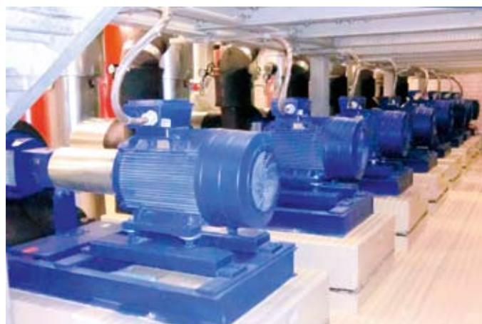
Normpumpen der Baureihe „Etanorm“ versorgen die RLT-Anlagen der Messehalle 11 mit Klimakaltwasser; die Pumpen liefern dafür Volumenströme von 450 bis 880 m<sup>3</sup>/h
