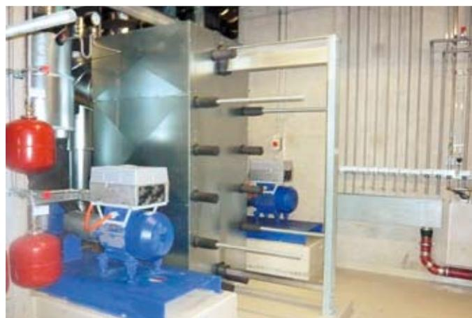
Bei abnehmendem Förderstrom registriert „PumpDrive“ einen Druckanstieg und passt abhängig vom vorgegebenen Solldruck die Drehzahl der Pumpe an; steigt der Verbrauch wieder an, reagiert die Drehzahlregelung auf den daraus resultierenden Druckabfall und erhöht die Pumpenleistung
