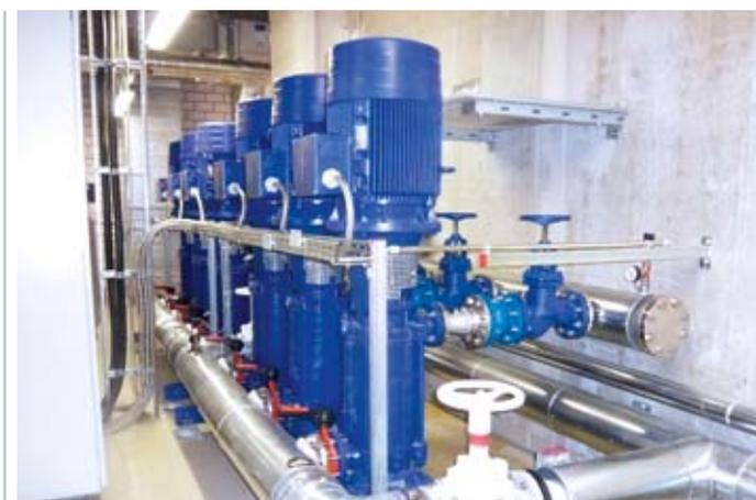
Vertikale Hochdruckpumpen versorgen von der Technikzentrale aus die auf dem Hallendach installierten, nach dem „Dry & Spray“-Prinzip arbeitenden Rückkühlwerke mit rund 20 bar Wasserdruck
