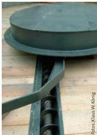
Austragsystem mit Spannfeder und Förderschnecke am Boden des Hackschnitzelbehälters
