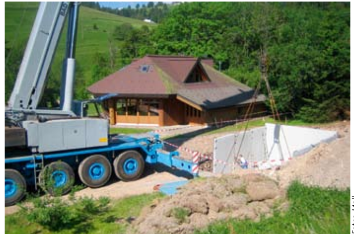
Die Beton-Fertigteile wurden mit einem Kran an die vorgesehen Stellen gesetzt
