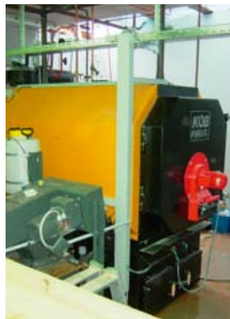
Hackschnitzelkessel 220 kW in der unterirdischen Heizzentrale
