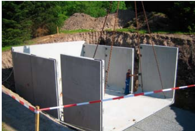
Versetzen der Beton-Fertigteile für das unterirdische Brennstofflager mit Heizzentrale
