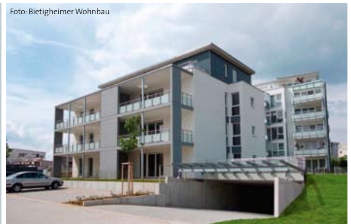
In diesem Mehrfamilienhaus in Bietigheim-Bissingen hat mit „Smart Metering“ und Energiemonitoring die Energietechnik von morgen bereits Einzug gehalten
