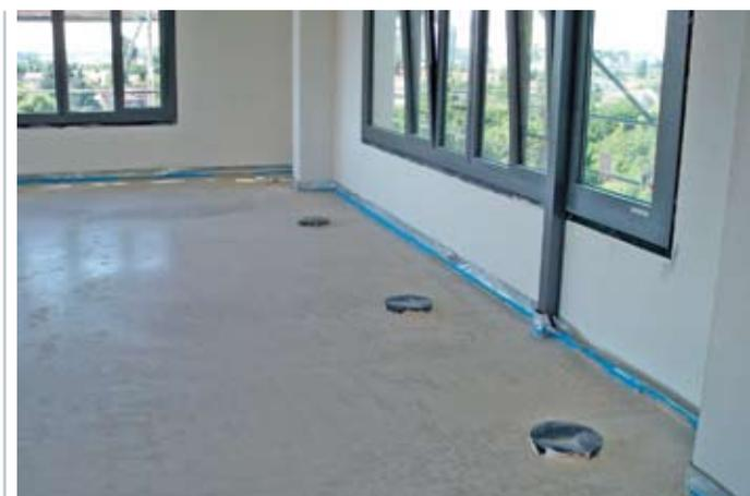
**Bild 6e: Der fertig verlegte Estrich**
