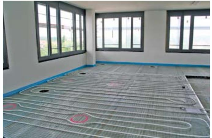
Bild 6a und b: Hohlraumboden (links) und Rohrinstallation (rechts)
