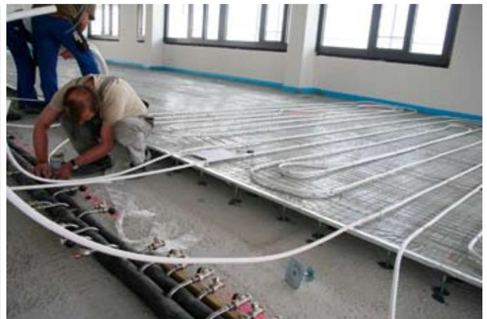
Bild 6c und d: Verlegung der Rohre (links) und Anschluss an die Hauptleitung (rechts)
