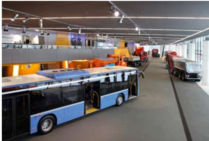
Die ganze Bandbreite von LKW und Bussen wartet auf Anfassern und Probesitzen: Temperiert wird die Halle über einen Industriefußboden (Heizen) oder über eine offene Kühldecke (Kühlen)
