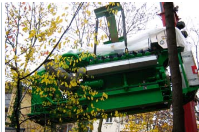
Die Einbringung der BHKW-Module in das 3. UG ...
