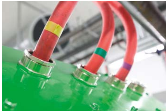
Der erzeugte Strom dient zur Grundlastversorgung der Klinik
