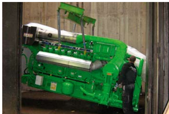
... erfolgte mit Hilfe eines Krans
