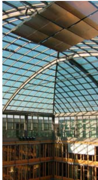
Bild 2: Glasdach über dem Innenhof als Regensammelfläche, Brandschutz für Innenhof-Fassade aus Holz durch eine Fassadensprühanlage mit Regenwasser
