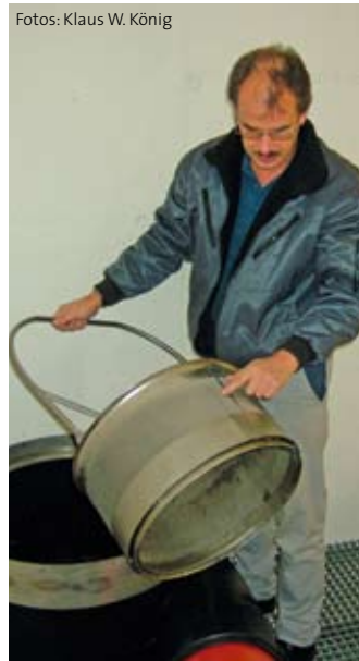
Bild 3: Regenwasserfilter, Entnahme des Filtereinsatzes zur Reinigung
