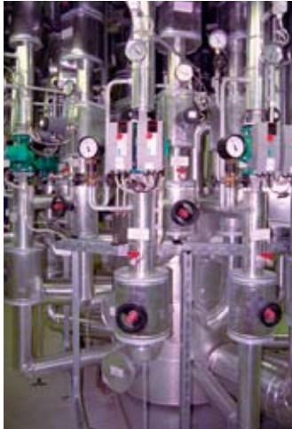
Bild 4: Das Zortström-Sammel- und Verteilsystem führt die Heizwasserströme von Wärmeerzeugern und Abnehmerkreisen auf einem hydraulischen Nullpunkt zusammen
