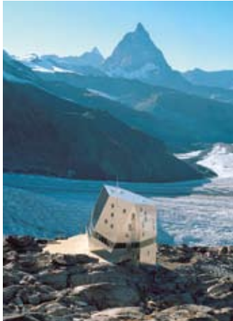
Die Hütte mit den PV-Kollektoren an der Südfassade
