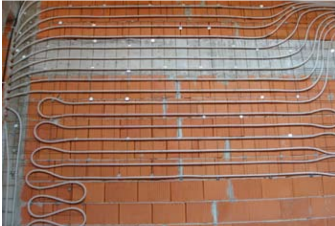
Die werkseitig gelieferten „Contec“-Module wurden direkt auf den bis zu 9 m hohen Betonwänden des Museums verlegt
