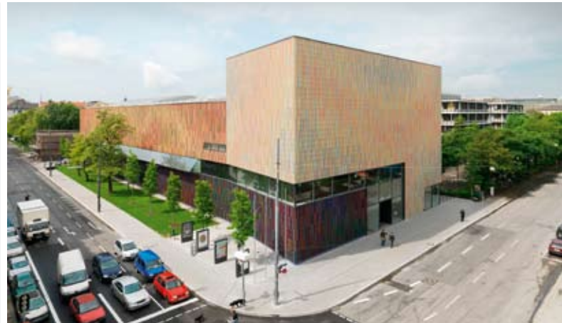
Das im Mai 2009 eröffnete Museum Brandhorst sorgt mit Wärmepumpe und Betonkernaktivierung für ein ganzjähriges Wohlfühlklima für Kunst und Besucher
