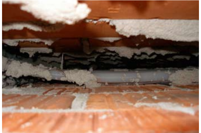
Die Zwischenräume wurden vollständig mit Flüssigbeton verfüllt; um eventuelle Luft einschüsse und damit eine Leistungsminderung der Betonkernaktivierung zu verhindern, erfolgte eine Überprüfung der Betonkernaktivierung mit einer Wärmebildkamera
