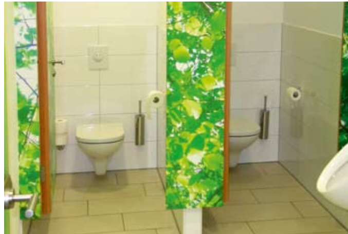
Die WC-Kabinen, in denen die wandhängenden Renova Nr. 1-WCs installiert sind, ziert ...
