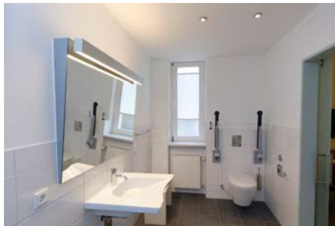
Der unterfahrbare Waschtisch, das mit Stützklappgriffen ausgestattete WC sowie das geneigte Lichtspiegelement erleichtern insbesondere behinderten Gästen die tägliche Hygiene
