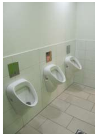
Auf den Herrentoiletten sind „Aller“-Urinale von Keramag installiert worden
