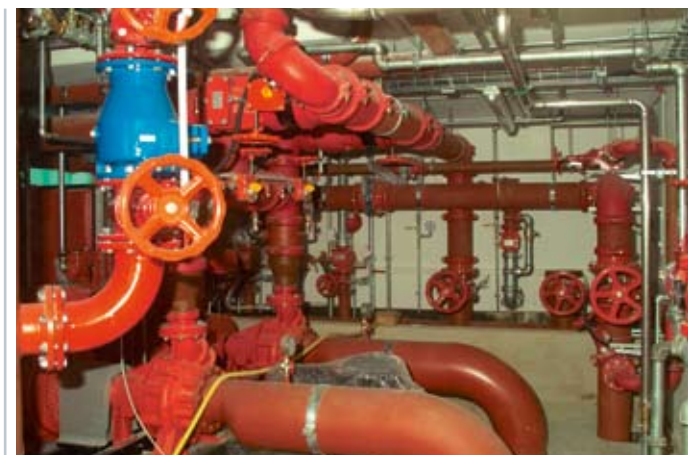
Auf engstem Raum befindet sich die Sprinklerzentrale, die bereits so ausgelegt ist, dass weitere Bauabschnitte von hier aus versorgt werden können
