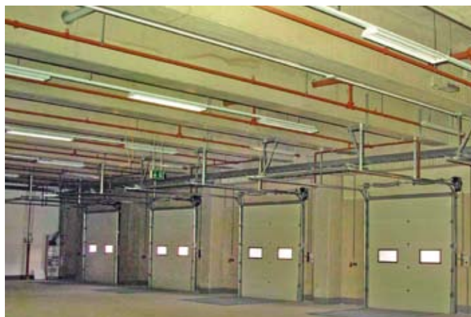
Für den großflächigen Versandbereich wird dem Sprinklersystem Schaum hinzugegemischt
