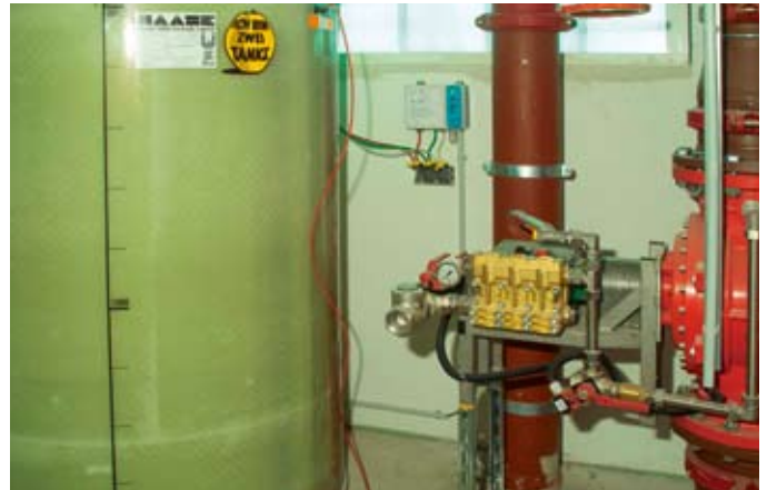
Über einen 2000 l-Tank wird Schaum in die Löschanlage eingespeist
