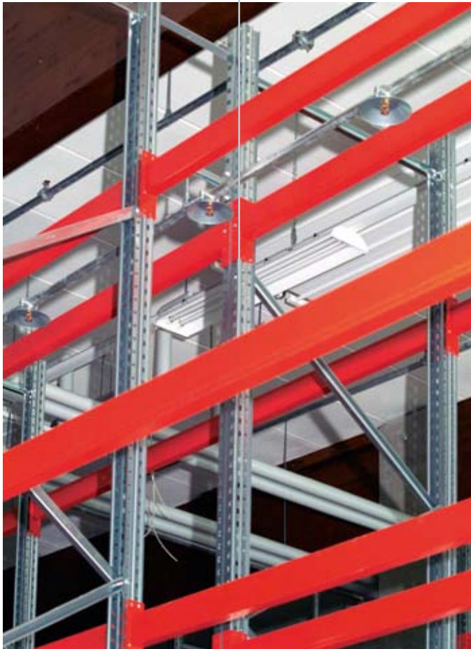
Zum Schutz eines Hochregallagers sind Sprinkler an der Decke sowie zwischen den Regalen erforderlich
