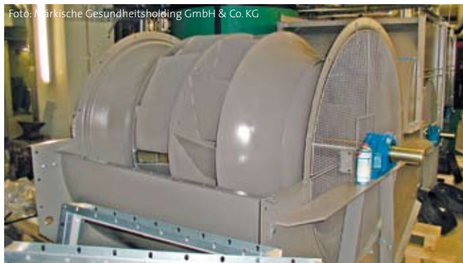
Bild 6: Einbau der neuen RLT-Anlagentechnik in die Bestandsgebäude
