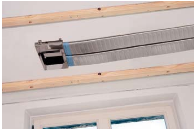
Bild 4: Für Bestandsgebäude hat Westaflex „Slimflex“ entwickelt, mit nur 25 mm Höhe ideal für abgehängte Decken
