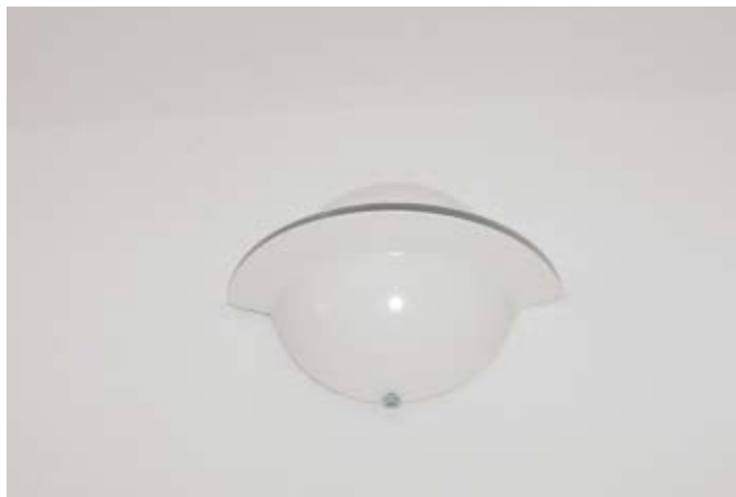
Bild 2b: ... in den Räumen installiert
