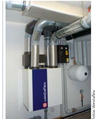
Bild 1: Das Zentralgerät – die Schaltstelle für die Reinigung und Wärmerückgewinnung
