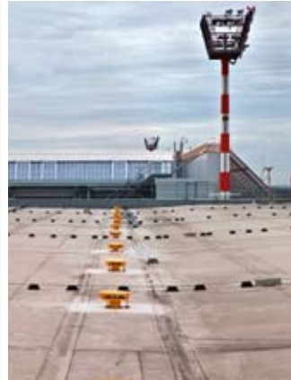
155 m weit erstreckt sich eine der beiden Notentwässerungslinien über das 11 000 m 2 große Flachdach (die gelben Anstaelemente befinden sich noch vor dem Feinjustierungsprozess)
