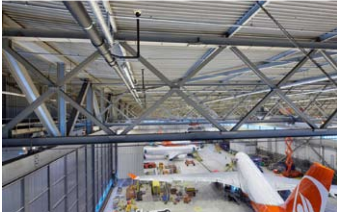
Sammelanschlussleitung mit Abzweigen zu den einzelnen Gullyanschlüssen
