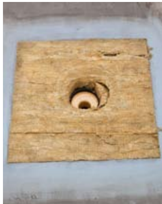
Die Wärmedämmung im Durchdringungsbereich des Daches wurde wieder ergänzt
