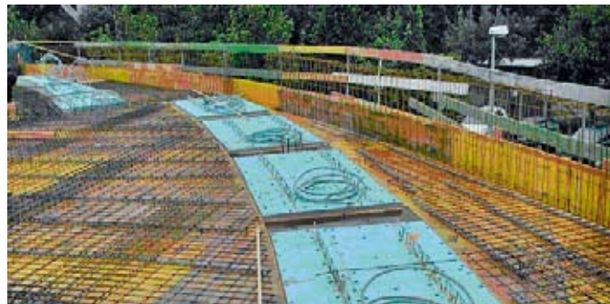
Bild 10 a und b: Thermisch getrennte Randzonelemente, fast unsichtbar integriert in die Geschosstrenndecke zur individuellen Einzelraumregelung
