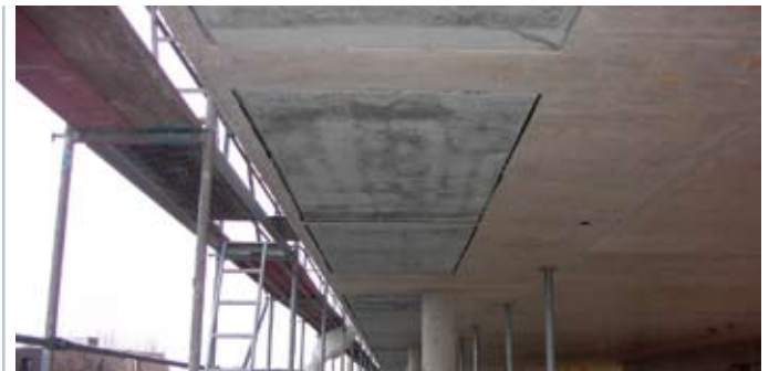
Bild 10 a und b: Thermisch getrennte Randzonelemente, fast unsichtbar integriert in die Geschosstrenndecke zur individuellen Einzelraumregelung
