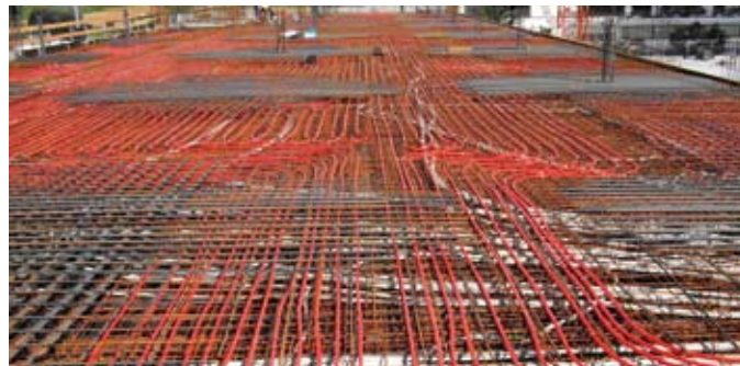
Bild 11: Aktivierte Geschosstrenndecke für die speicherbasierte Grundtemperierung a) und ein nach Spachtelung und Farbbeschichtung fast unsichtbares Randzonelement b)
