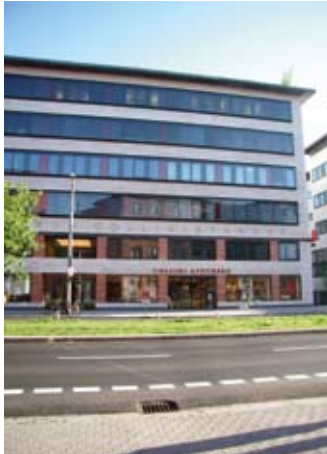
Bild 2: Das Gebäude umfasst vom UG bis zum 6. OG sieben Etagen
