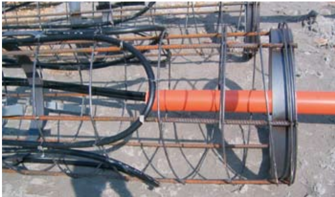
Bild 4: mit a) Herstellung des Energiepfahls, ...
