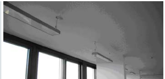
Bild 11: Aktivierte Geschosstrenndecke für die speicherbasierte Grundtemperierung a) und ein nach Spachtelung und Farbbeschichtung fast unsichtbares Randzonelement b)
