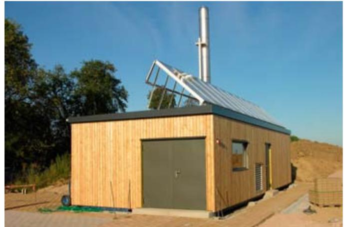
In der Energiekabine sorgen ein Pelletsheizkessel und drei BHKW für die Wärme im Bürogebäude
