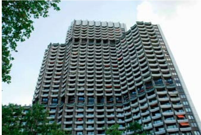
Kennzeichnend für das knapp 100 m hohe Gebäude ist der dreistufige turmförmige Aufbau mit einer wabenförmigen Balkonstruktur
