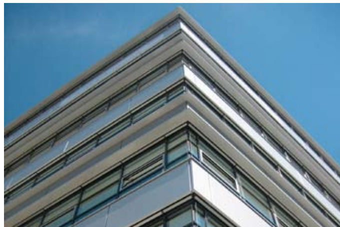
Ein Fassadendetail kurz vor Fertigstellung des Gebäudes
