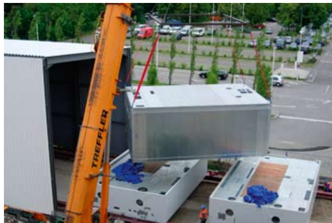
Bild 3: Die vorgefertigten Zellen werden – in zwei Teile zerlegt – mit dem Tieflader angeliefert, vor Ort zusammengesetzt und in das Gebäudeskelett eingeschoben
