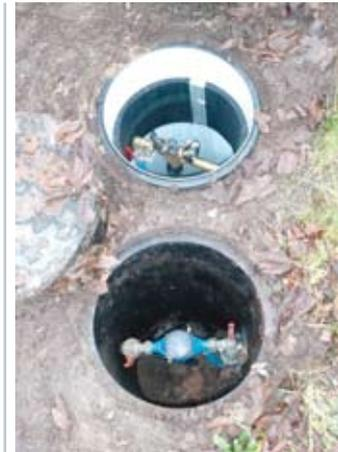
**Bild 4: Systemtrenner dürfen niemals in Schächten oder Räumen installiert werden, die überflutet werden können**
