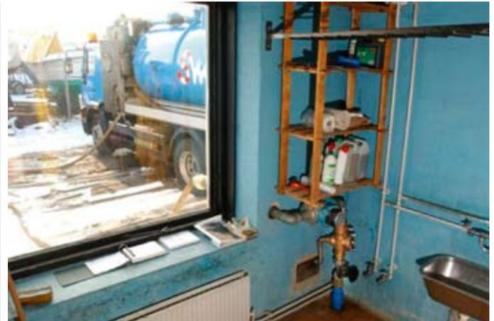
**Bild 5: Systemtrenner dürfen niemals senkrecht installiert, um die vollständige Entleerung der Mittelkammer zu gewährleisten**
