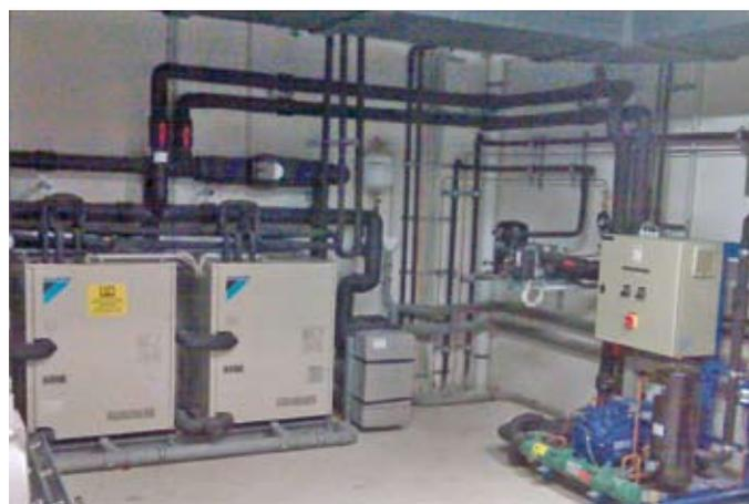
**Bild 7:** Die Technikzentrale, links die Grundwasser-VRV, rechts die Gewerbekälte
