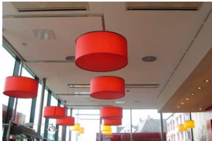
Bild 4: Die vier 2-seitigen Kassettengeräte mit je 9 kW Kühlleistung
