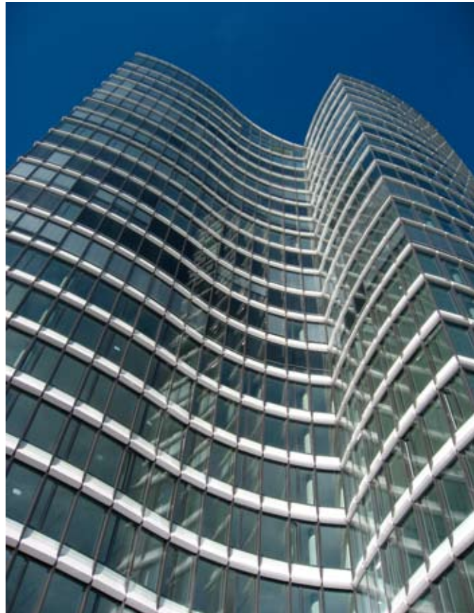
Das Sky Office ist 89 m hoch und hat 23 Stockwerke
