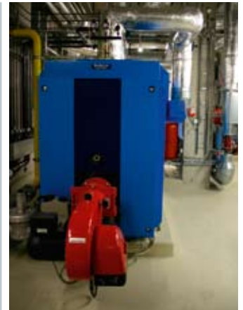
Der Gasheizkessel dient der Grundlastversorgung des Gebäudes, das zudem an das Fernwärmesystem des Messegeländes angeschlossen ist
