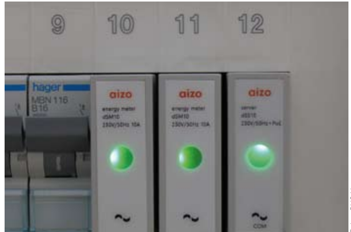
Der digitalSTROM-Server (rechts) kommuniziert via Internet; die beiden digitalSTROM-Meter bilden mit den eingebauten dSID-Chips die eigentlichen digitalSTROM-Gruppen
