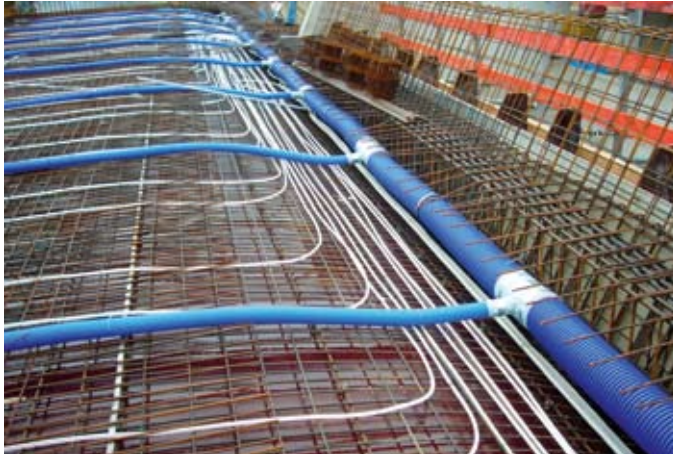
Neben der Betonoberflächenaktivierung wurde ...
