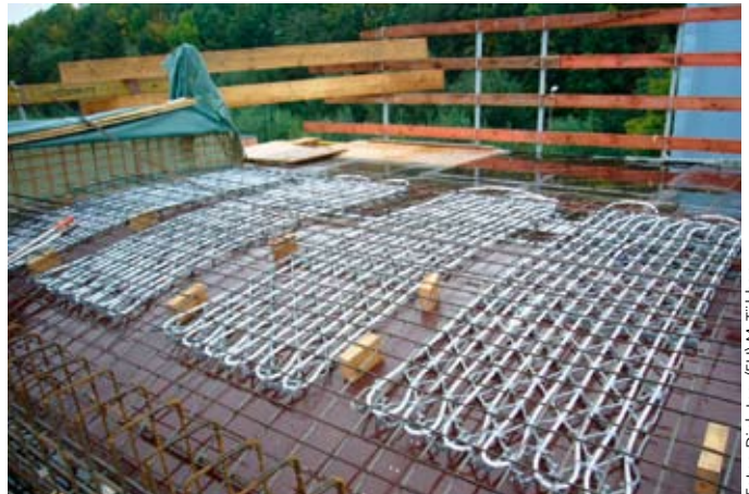
Auch bei der kuppelförmigen Dachkonstruktion des neuen Verwaltungsgebäudes konnten die „Contec ON“-Module zügig montiert werden
