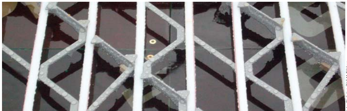
Für das neue Verwaltungsgebäude in Zolling wurde die „Contec ON“-Hochleistungsvariante von Uponor mit einem Rohrabstand von 85 mm auf einer Fläche von insgesamt 1200 m 2 installiert
