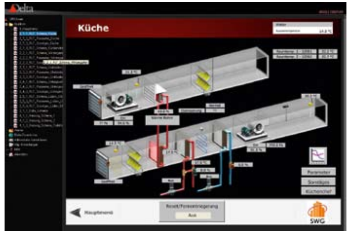
Fernbedienung: Auf die Gebäudeleittechnik besteht innerhalb des Hauses und – für autorisierte Nutzer – via Internet Zugriff. Das erlaubt Einstellungen und Diagnosen aus der Ferne
