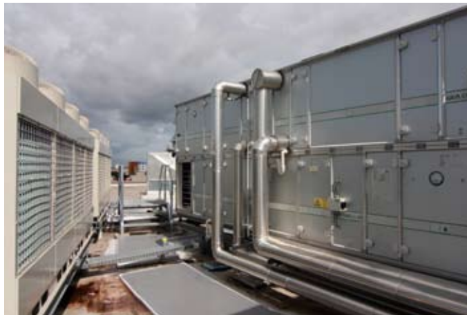
Dachlandschaft mit Zentralanlagen: Die meisten Lüftungsgeräte (rechts ein GEA Cair) und Kaltwassererzeuger befinden sich auf dem Dach und versorgen von hier aus Büros und Küche mit konditionierter Luft
