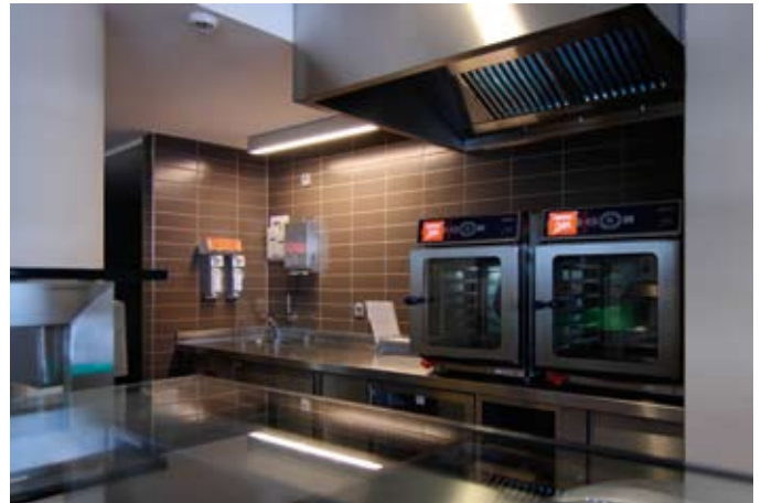
Lüftungstechnisch anspruchsvoll: Die Speisenzubereitung nahe der Essensausgabe verlangte eine ausgefeilte Lösung
