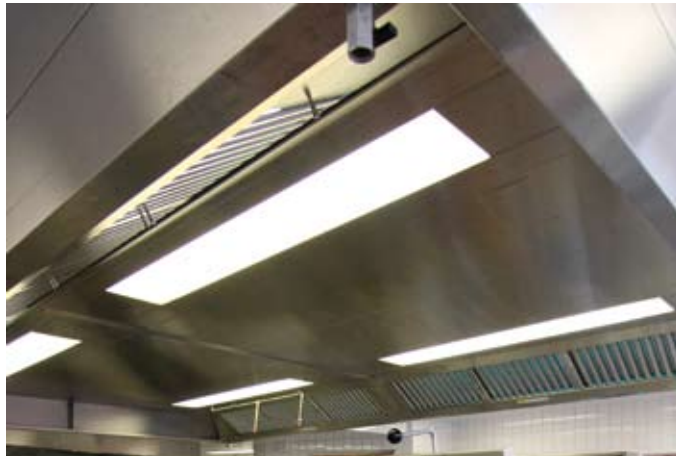
Macht Gerüchen den Garaus: Eine Küchendecke saugt Dunst und Fett ab und neutralisiert die Gerüche
