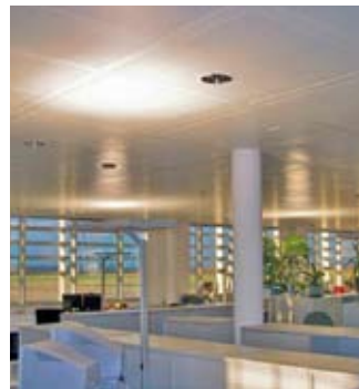
Bild 9: Die einzelnen Metallplatten sind akustisch wirksam und zudem abnehmbar
