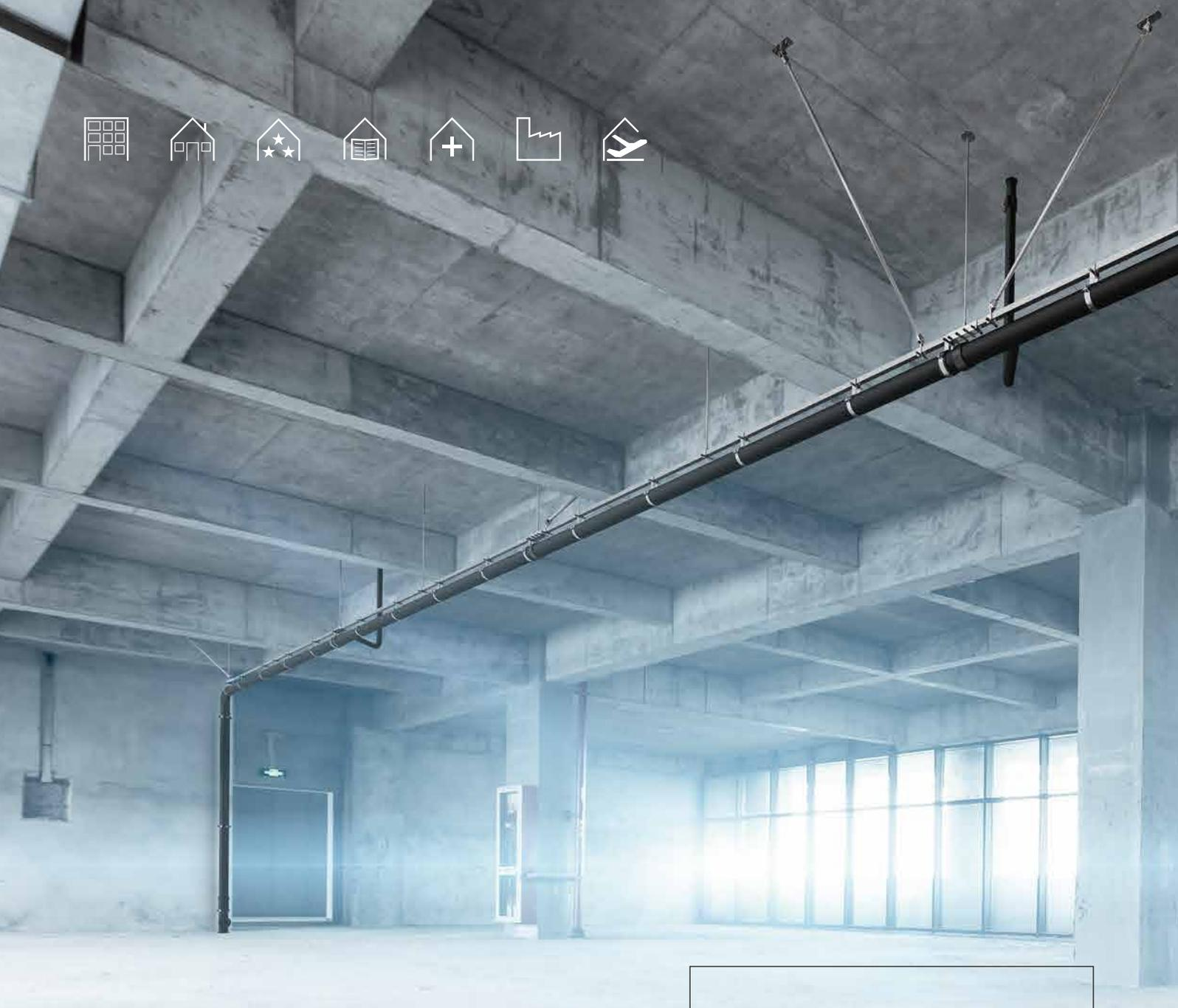
Beim Einbau des Unterdruck-Dachentwässerungssystems kann es unter ungünstigen Randbedingungen zu Vibrationen im Rohrleitungssystem kommen. Mit dem Abstützungsset bietet Geberit eine attraktive Lösung, um Vibrationen zu vermeiden. Es eignet sich zur tiefhängenden Montage der Befestigungsschiene bei horizontalen Leitungsbefestigungen.
