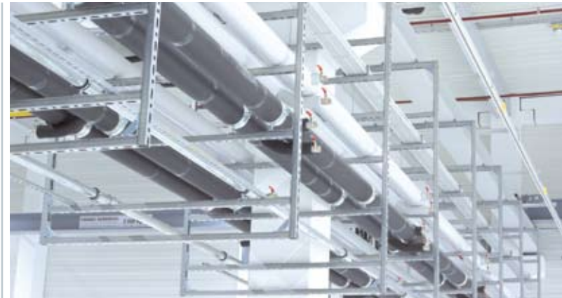
Bild 1: Moderne Montageschienensysteme sind hochflexible Konstruktionsbaukästen für vielfältige Anwendungsbereiche
